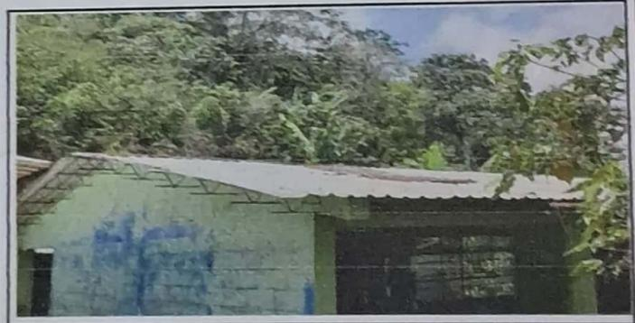
MODULO 1: Sustitucion de lamina troquelada c/26 15 pies 4to a 5to. Grado
